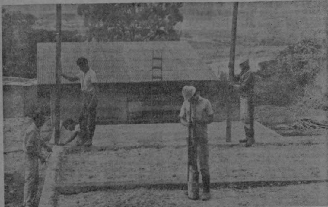
ASI SE LEVANTA ESTA CIUDADELA. Los propios beneficiados y gentes de Calle Loaiza, trabajan en la construcción de esta hermosa ciudadela, fruto del esfuerzo y la voluntad de una Comunidad organizada, a la que I.M.A.S. supo dar respuesta.
